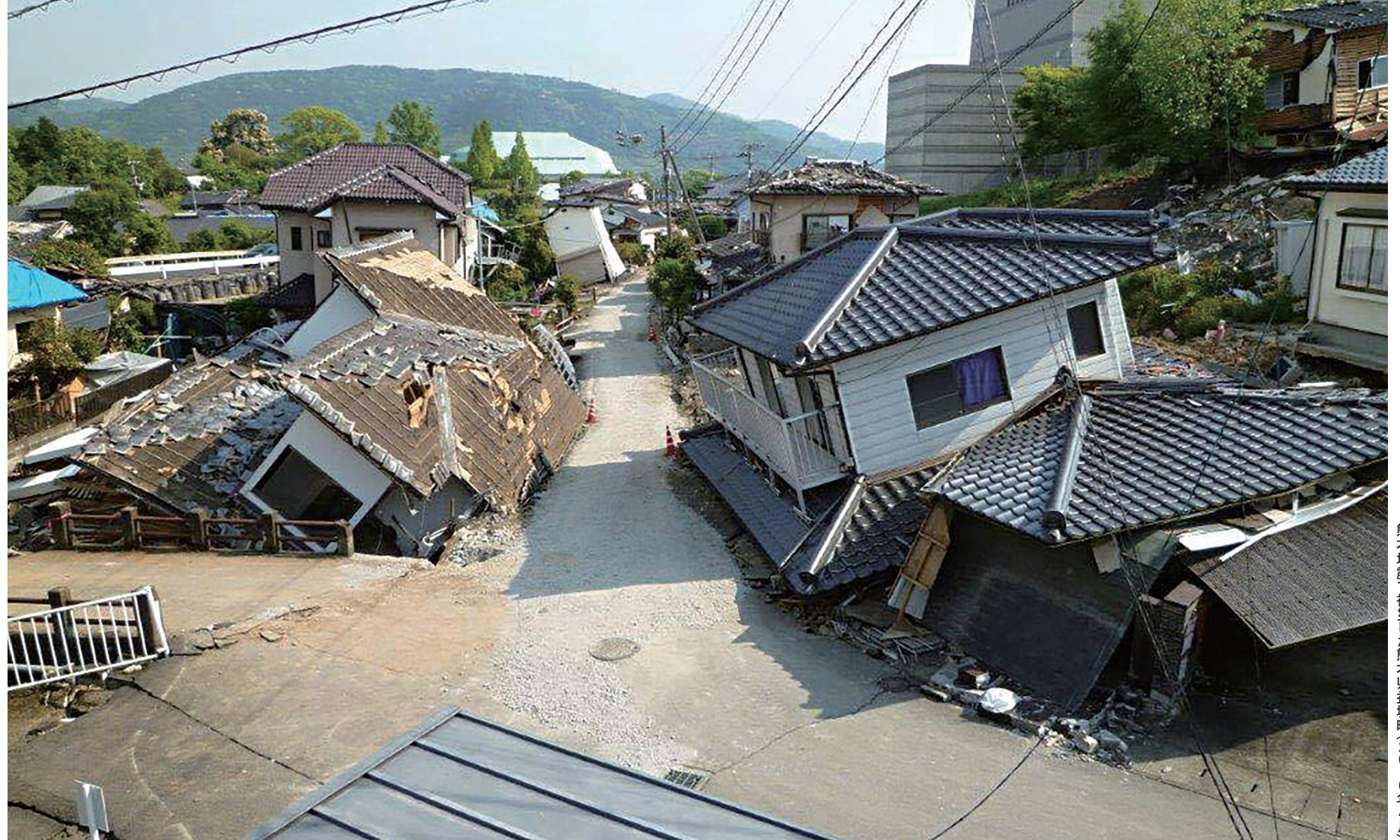
熊本地震で被災した熊本県益城町(2016年4月)
